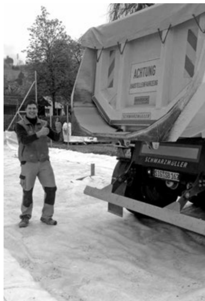
Sieben 40-Tonnen-Lastwagen füllen das Beachvolleyballfeld mit Spezialsand
