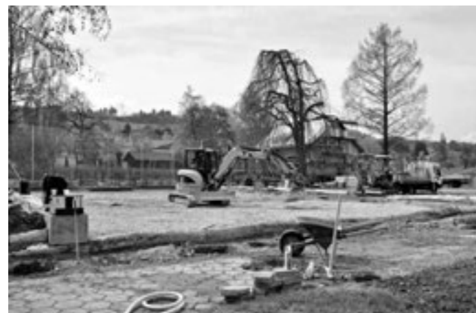
Vorbereitungsarbeiten für das Beachvolleyballfeld oberhalb des Fussballplatzes
