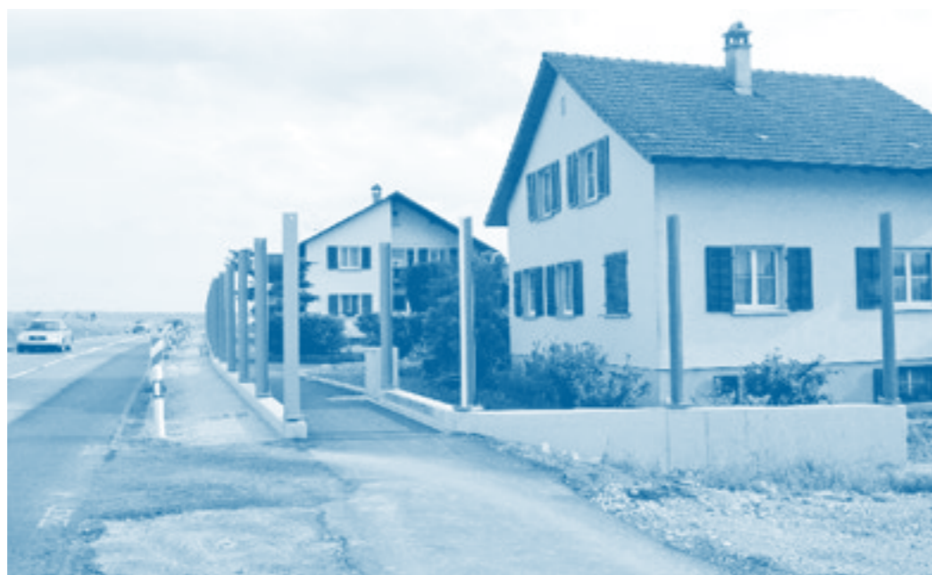
Die Lärmschutzwände im Gebiet Riedmatt werden bis Ende Juli fertig montiert sein
