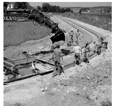
Einbau der Betonspuren im Bereich des Wildtierkorridors
