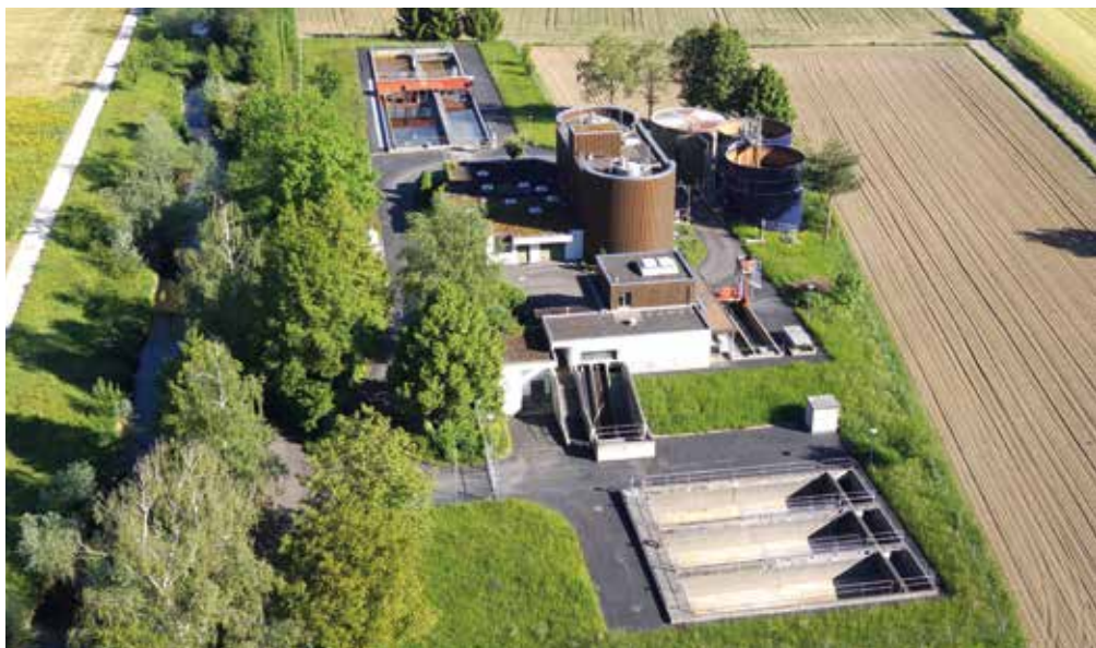
ARA Chlostermatte – am unteren Bildrand die Regenbecken und oben die Vor- und Nachklärbecken mit dem roten Räumler
