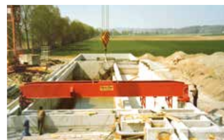
Montage des Räumers über den Beckenblöcken
